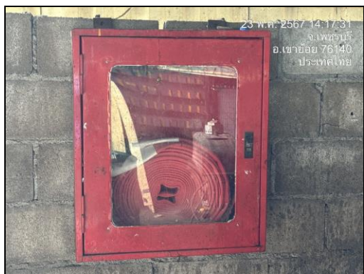
ภาพที่ 21 ตู้เก็บสายฉีดน้ำดับเพลิง
